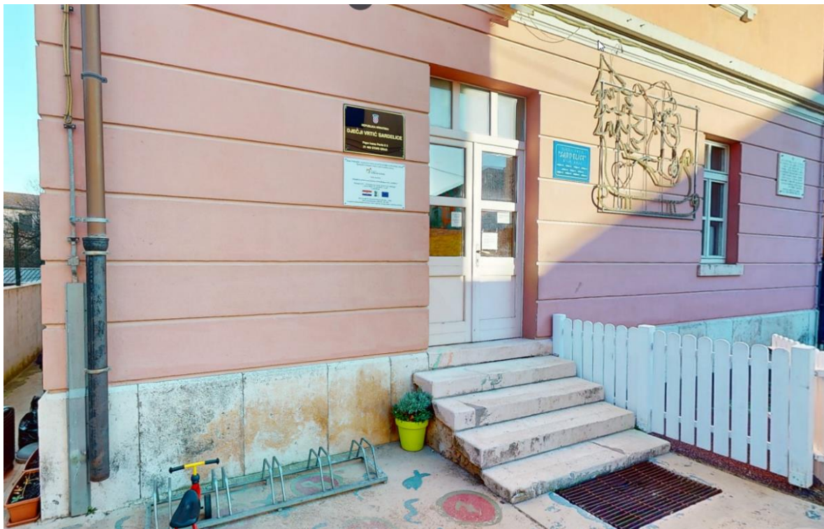
Postojeće stanje – pozicija nadstrešnice iznad ulaza
